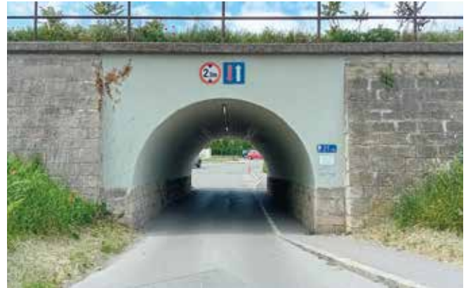
Die Tunnelrundbogen in der Gartengasse wird begradigt.
